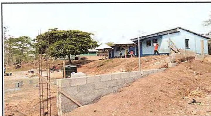
Foto 3: Trabajando en el muro perimetral
