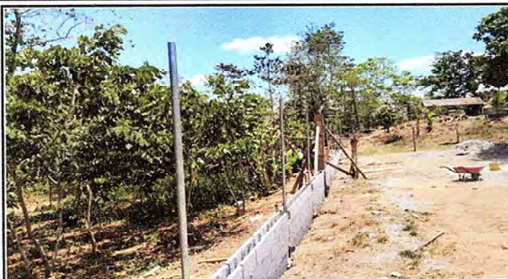
Foto 1: De esta manera esta quedando el muro perimetral
