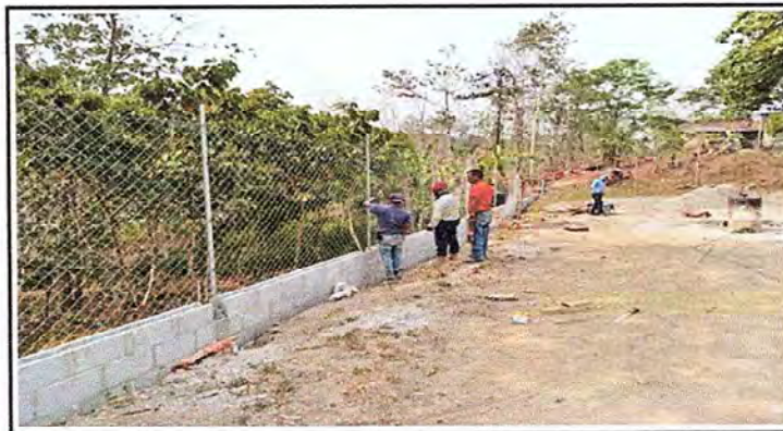
Foto 4: Colocando la Malla del muro perimetral
