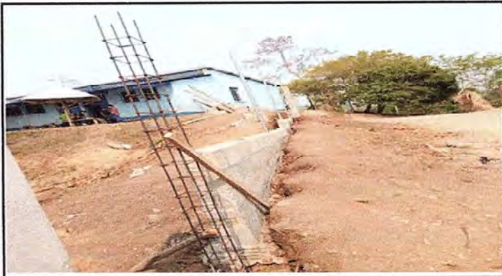
Foto 2: Muro perimetral de la parte de enfrente de la calle
